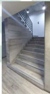
Ilustración 9 Escala de tránsito y evacuación
